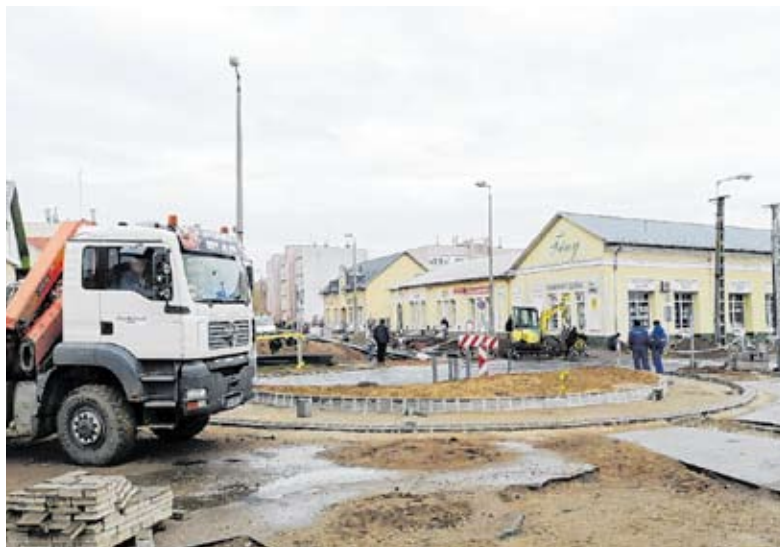
A körforgalom építése is jó ütemben folyik
