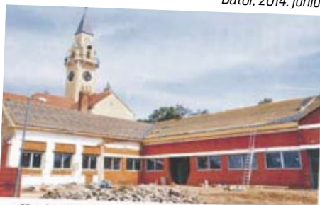
Heteken belül befejeződik a Kormányablak épületének külső felújítása
