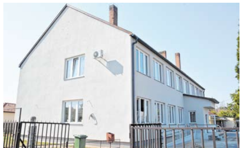
A ZENEISKOLA FELÚJÍTÁSA is folyamatban van, a külső és a belső munkálatokkal jól halad a kivitelező. Felkerültek a fűtőszálak és megkezdődtek az átalakítások. Előreláthatólag október elejére kész lesz a megújult iskola.
